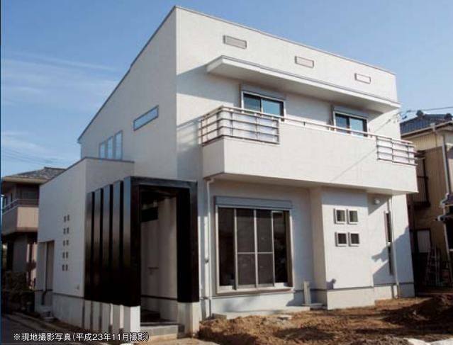
※現地撮影写真(平成23年11月撮影)
