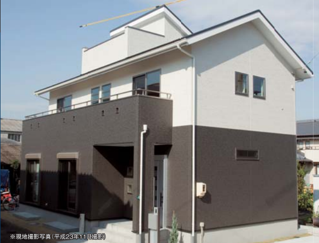
※現地撮影写真(平成23年11月撮影)
